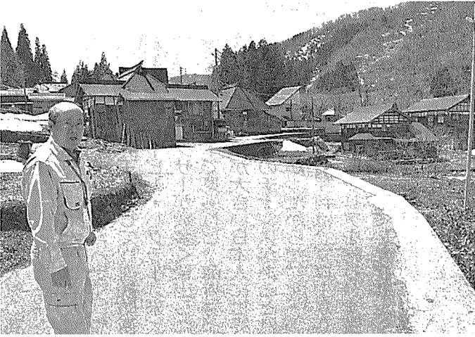
「道直し」で整備された道路。除雪車が入れるようになった。長野県栄村
