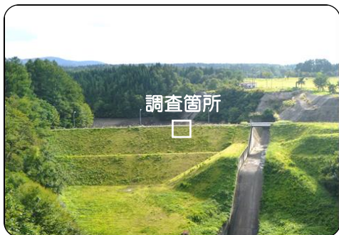
① ダム堤体下流側全景
