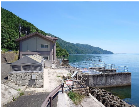
余呉湖補給揚水機場
