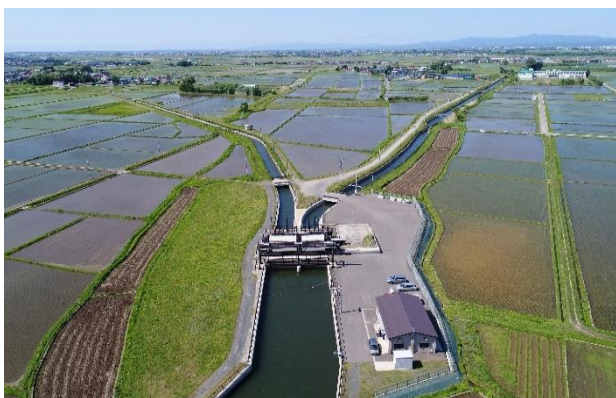
土淵堰の野木分水工
