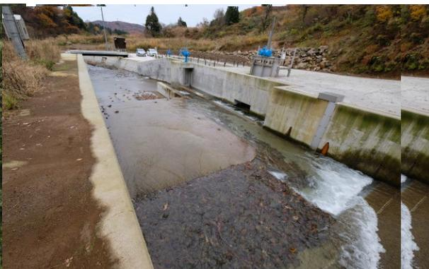
写真4.取水工詳細(運用状況)
