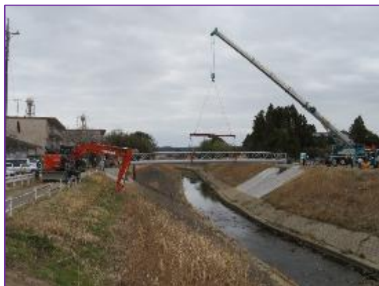
写真3. 200t吊りクレーンによる架設状況
