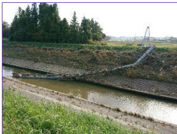
写真1.被災した水管橋
