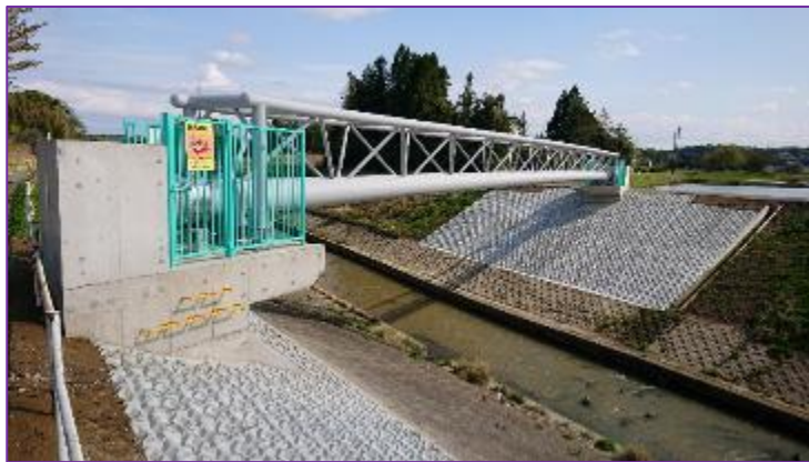
写真4.完成後の水管橋全体写真
