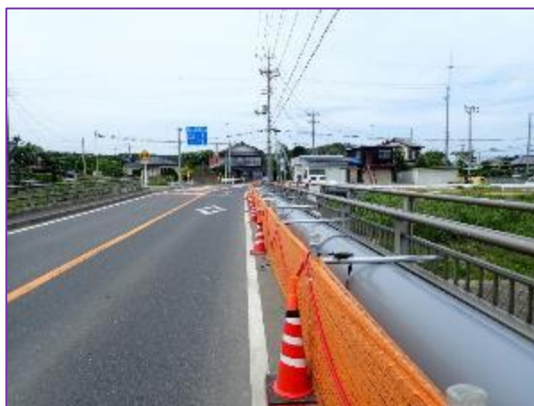
写真2.既存道路橋を利用して仮廻し管を設置
