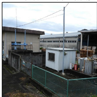
①旧排水機場
