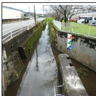
②排水機場につながる排水路
