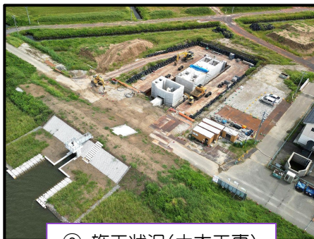
② 施工状況(土木工事)
