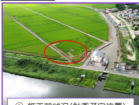
① 施工前状況(計画予定位置)
